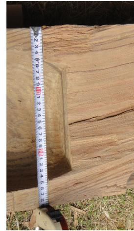
③ 高さ・深さ 左端：153mm 左端穴深さ：80mm 円形溝開始深さ：70mm
